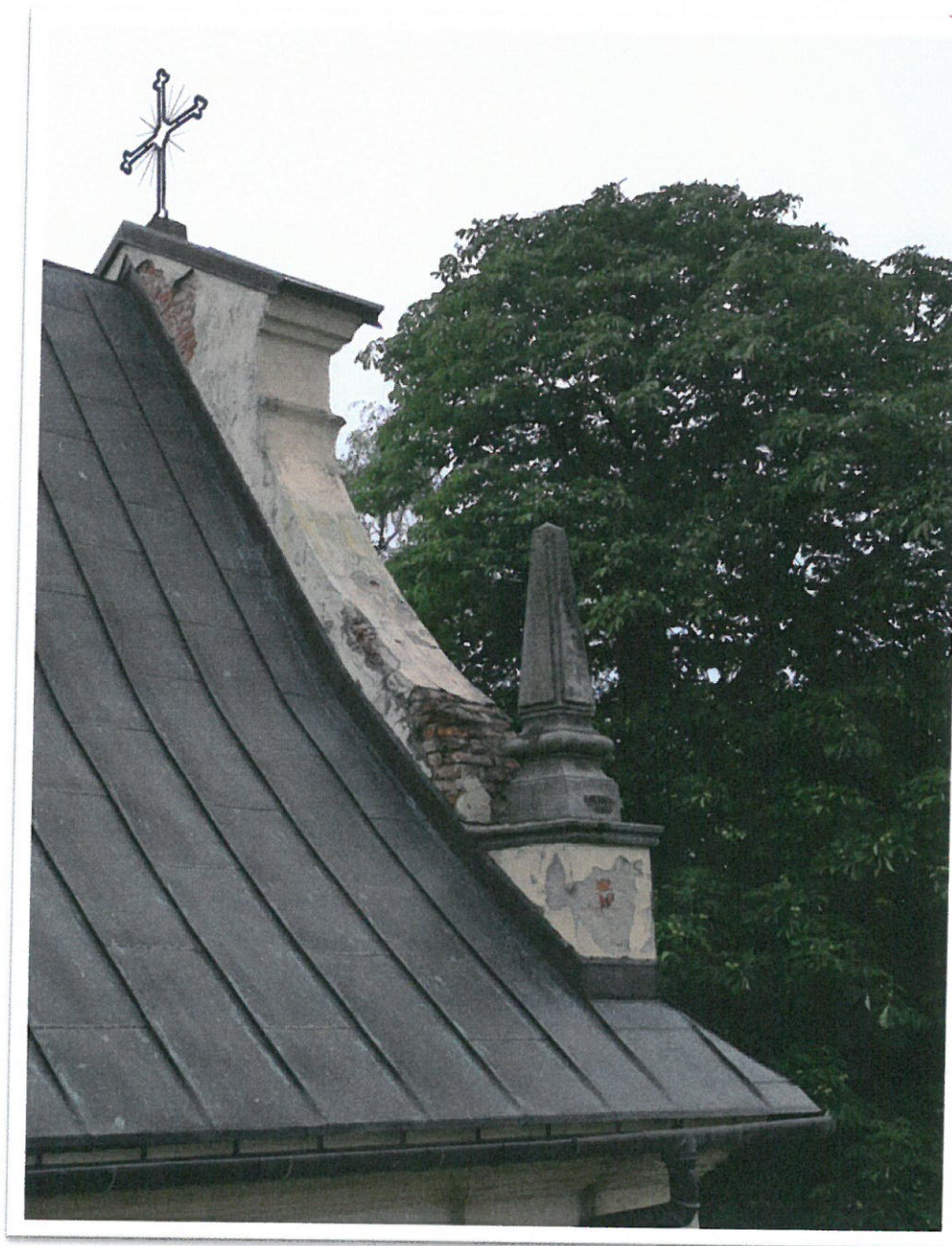
Foto 14. Uszkodzenia tynku i muru ściany szczytowej elewacji wschodniej
