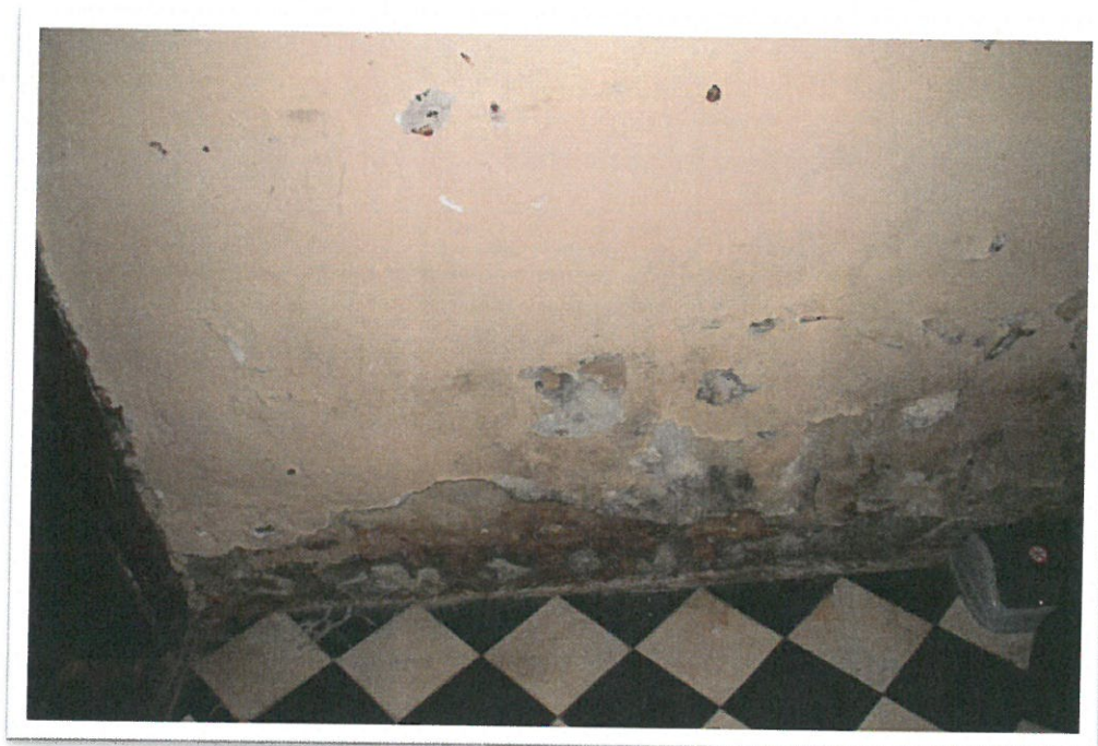
Foto 17. Uszkodzenia tynków wewnętrznych.
