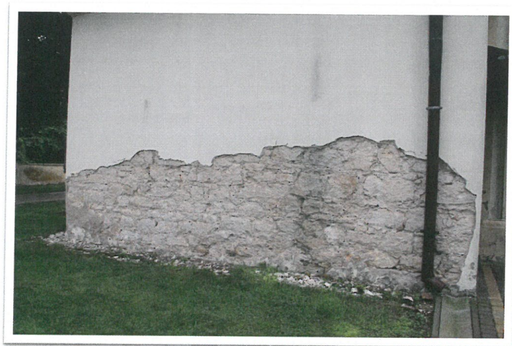
Foto 10. Uszkodzenia na elewacji północnej
