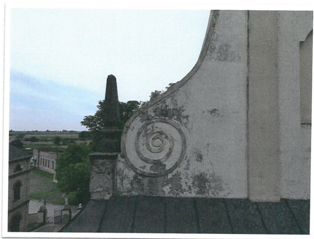
Foto 13. Uszkodzenia tynku ściany szczytowej elewacji wschodniej
