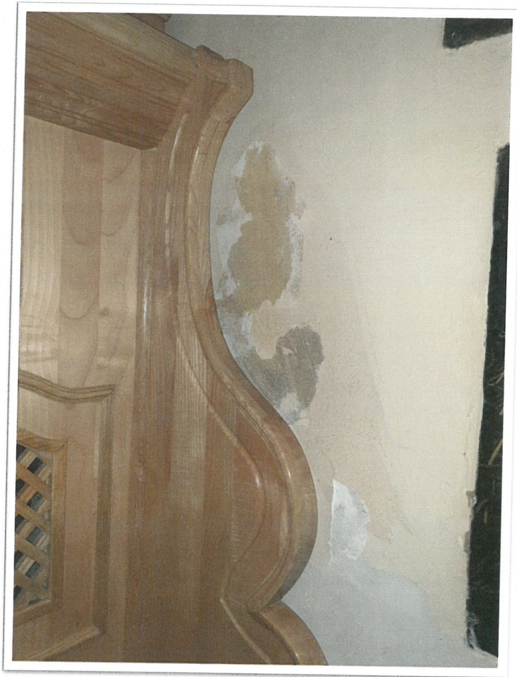
Foto 15. Uszkodzenia tynków wewnętrznych
