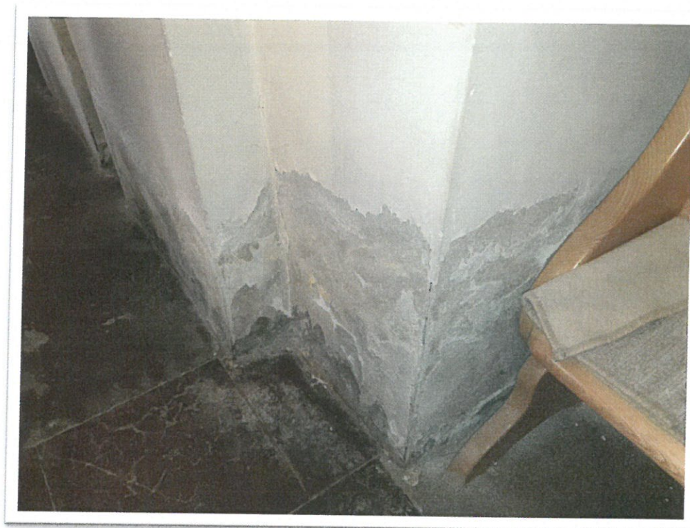
Foto 16. Uszkodzenia tynków wewnętrznych
