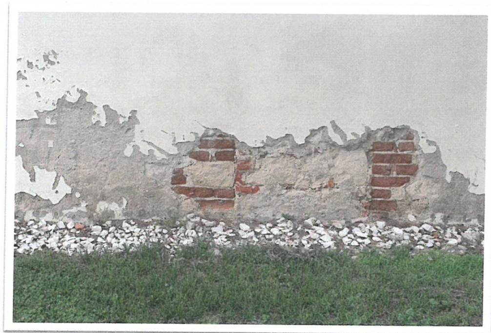
Foto 12. Uszkodzenia na elewacji wschodniej
