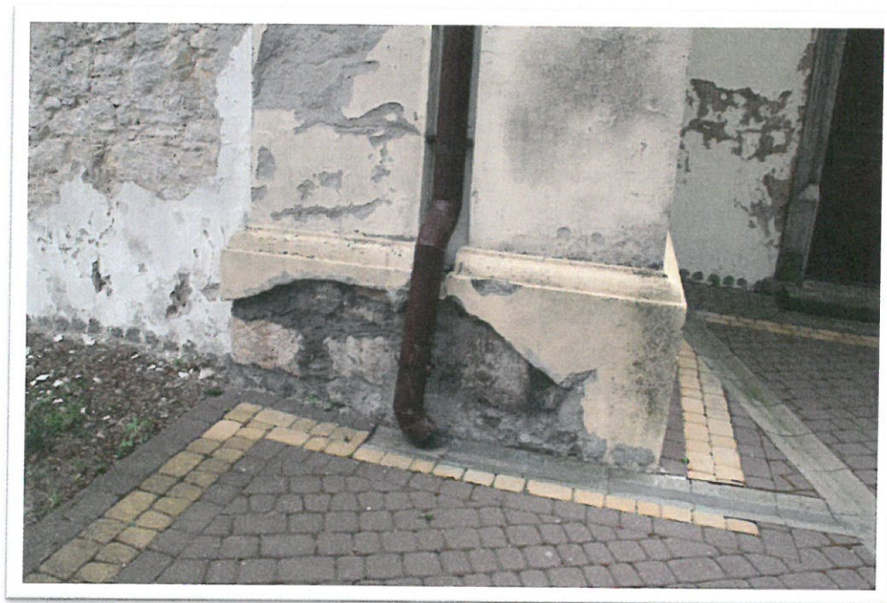
Foto 11. Uszkodzenia na elewacji północnej
